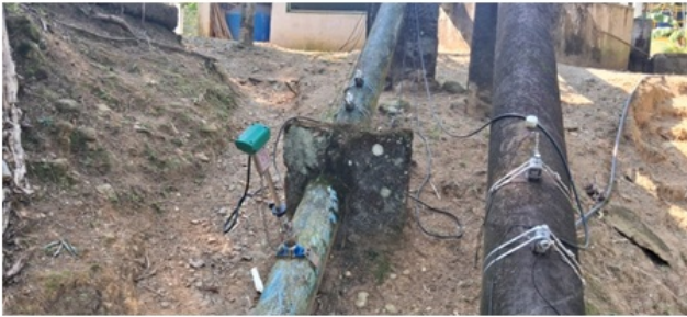
Foto 7 – Adutoras de água bruta, dotadas de medidores ultrassônicos de vazão e telemetria.
