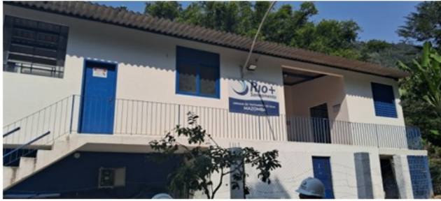
Foto 5 – Placa de identificação da estação.
