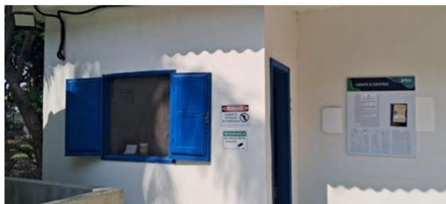
Foto 20 – Edificações que abriga o laboratório.
