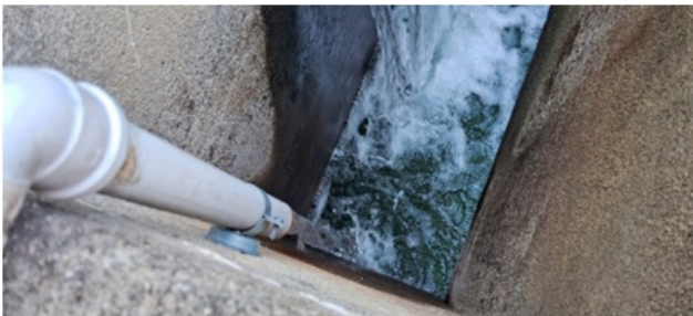
Foto 9 – Ponto de aplicação e mistura da solução desinfetante na água bruta.
