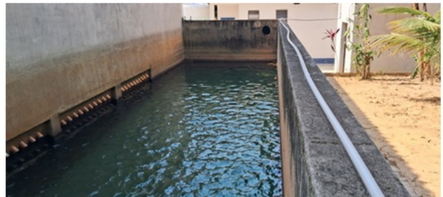
Foto 10 – Vista do tanque de desarenação logo após a aplicação da solução desinfetante. À esquerda localizam-se as tubulações de ligação entre as duas câmaras.
