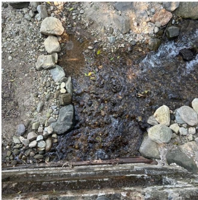
Foto 2 – Gradeamento da captação.
