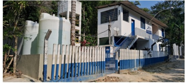
Foto 6 – Vista geral da ETA.
