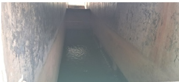
Foto 11 – Vista, de montante para jusante, do tanque de desarenação em sua parte coberta (segunda câmara).
